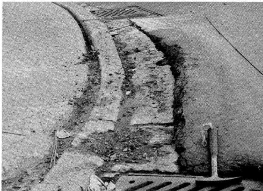
Figura 1.2: Vereda de hormigón afectada por la RAC, en Lancaster, Canadá. La expansión del hormigón empujó el cordón 9 cm hacia la derecha, deformando el pavimento asfáltico (Williams y Rogers, 1991)
