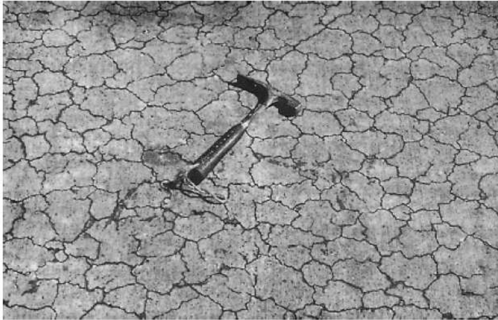
Figura 1.3: Fisuración típica en forma de mapa de una losa de hormigón afectada por la RAC (Ozol, 2006)
